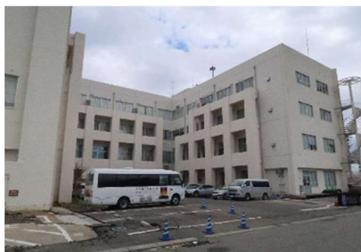
(a) 補強外観 (地上部分のみ)
