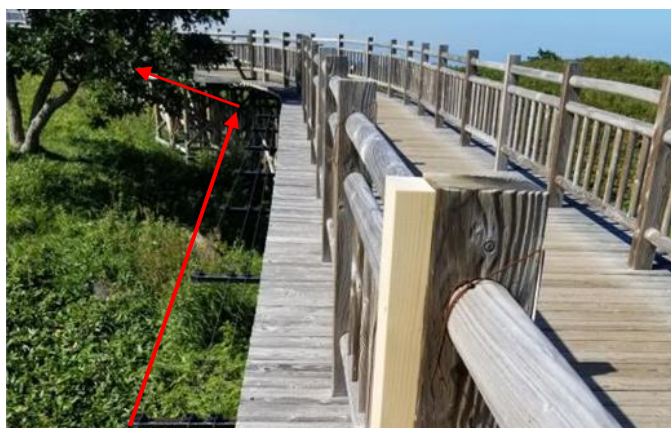
ヒグマ侵入防止のための電気柵（高架木道）
