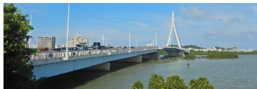
▲国道329号老朽化対策(とよみ大橋)
