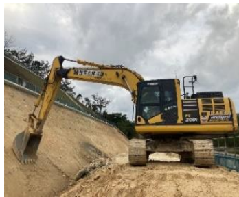
▲ICT 土工施工状況
