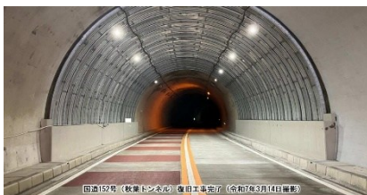
国道152号（秋葉トンネル）復旧工事完了（令和7年3月14日撮影）
