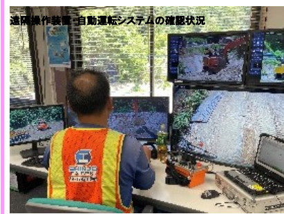
▲砂防事業における無人化施工の取組
