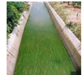
配慮対策施工後の水路
