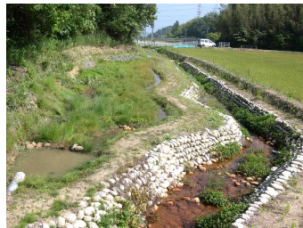
地盤面の切り下げ後に施工されたバイオトープ
