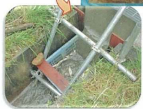
①外来魚類の流出防止を 目的としたカゴの設置
