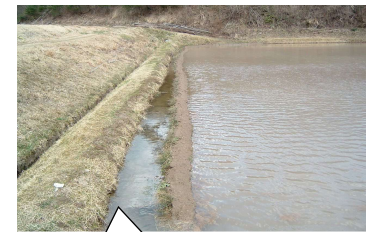
小水路の設置状況
