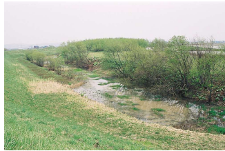
施工後における回避区間の状況
