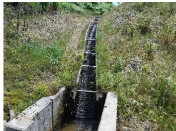
波付きフリュームの設置状況
