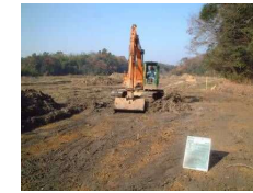
現況表土埋め戻しまでを実施
