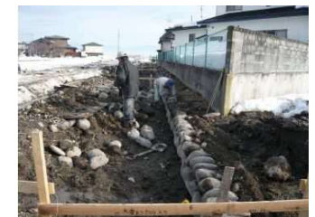
石積み水路の改修
