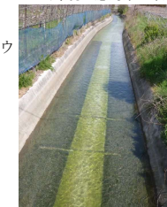
環境配慮対策改善後の水路
