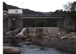
頭首工（改修前）
