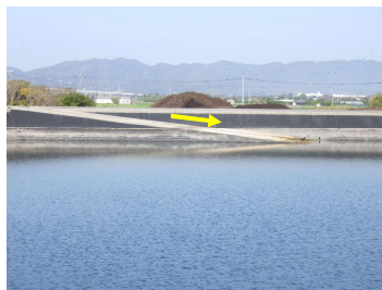
施設内へ下りるスロープの設置例
