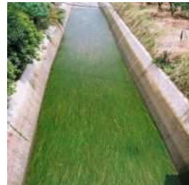
環境配慮対策施工後の水路
