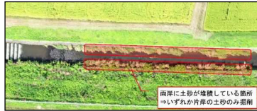
実証区間の二面装工区間
