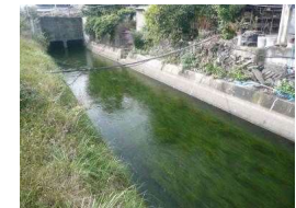
環境配慮対策実施後の水路
