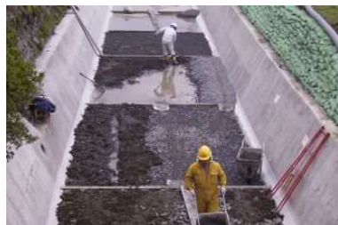
環境配慮対策施工状況
