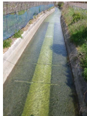
環境配慮対策改善後の水路
