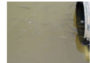
電線管の排水路側末端に集まる魚類
