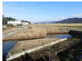
ナガエツルノゲイトウが侵入した循環かんがい施設の浄化池で、水田内に入ることから、送水が止められた事例
