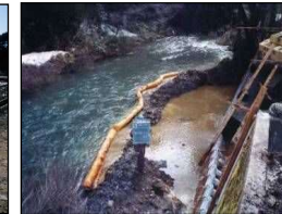
濁水防止フェンスによる抑制
