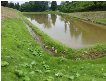
「江」の設置状況
