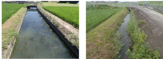
経年変化により水生生物の生息・生育環境が創出されたコンクリート水路の例
