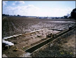
水田を借り入れ沈砂池として利用
