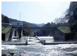
頭首工（改修後）
