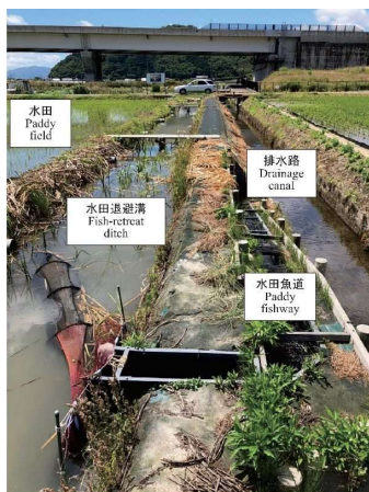
水田退避溝の設置状況
