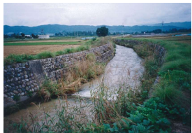
現況の排水路の状況(流速が速く、魚類の産卵場・生息場としての質は高くなかった)
