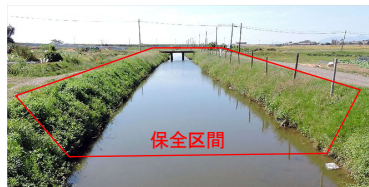
回避された土水路
