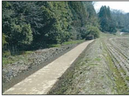
現況水路保全区間
