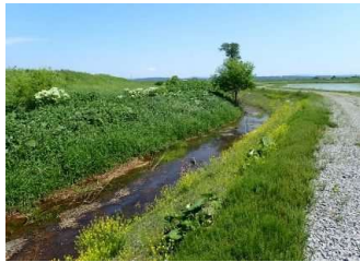
事業前の新千代北排水路下流部の状況
