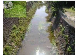
事業実施前の水路
