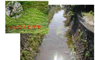
事業実施前の水路
