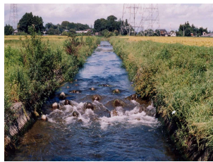
整備後の状況（急勾配側の左岸は流れが速く流量が多い、緩勾配側の右岸は水深が浅くなっている）
