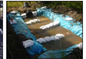
沈砂池に粗朶を入れ、土粒子の付着を促進
