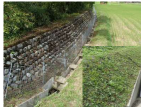
蓋版工の状況
