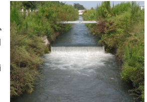
現況の状況 (落差工により、魚類等の移動経路が分断されていた。)
