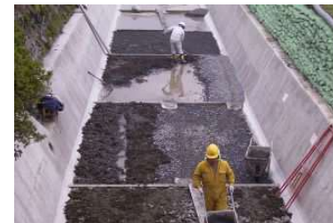
環境配慮対策施工状況
