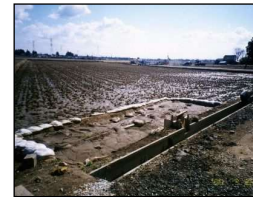
水田を借り入れ沈砂池として利用
