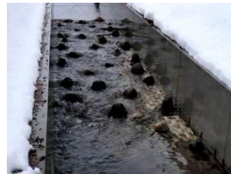
全断面魚道の例（下舌・上黒谷地区（福井県大野市） 出典）農林水産省農村振興局整備部設計課（2011）・水田生態系の保全に視点をのいた整備技術の解説書
