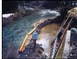
濁水防止フェンスによる抑制
