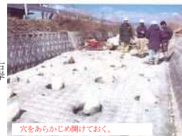
高強度マットにより形成された斜面に粗石を設置した状況
