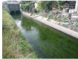
環境配慮対策実施後の水路
