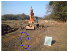
現況表土埋め戻しまでを実施
