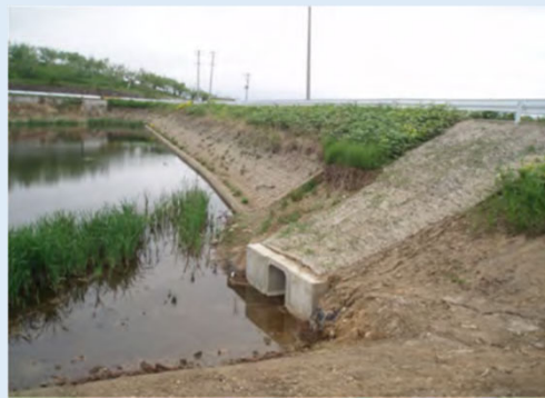
暗渠工法によるため池廃止事例
