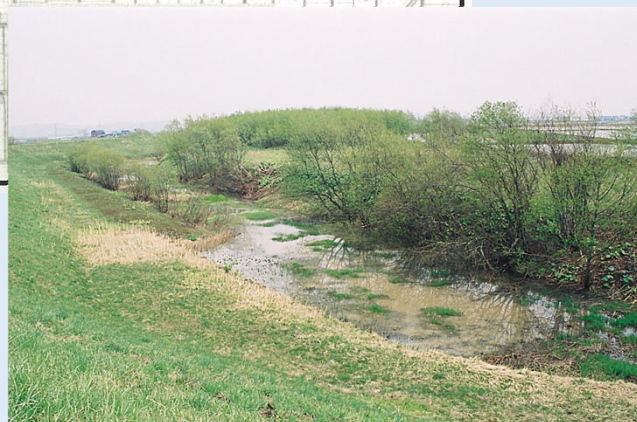
施工後における回避区間の状況
