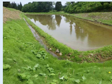
江の設置状況
