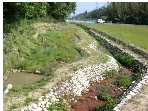
地盤面の切り下げ後に施工されたビオトープ
