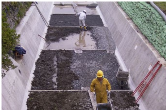
環境配慮対策施工状況
