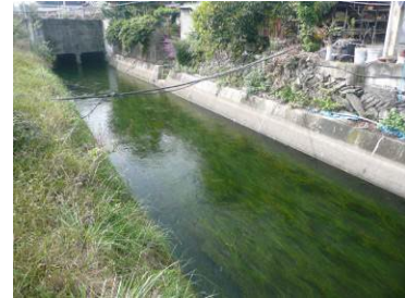
環境配慮対策実施後の水路
