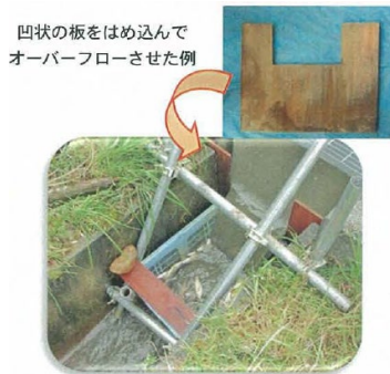
①外来魚類の流出防止を目的としたカゴの設置
