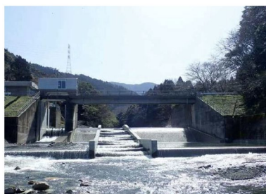
頭首工（改修後）
