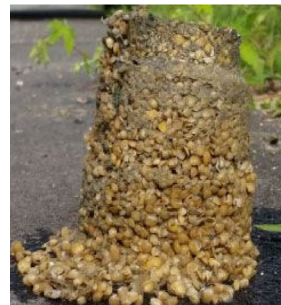
ストレーナーの詰まり
