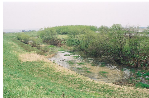
施工後における回避区間の状況
