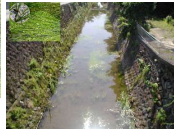
事業実施前の水路
