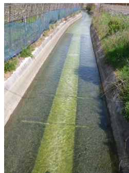
環境配慮対策改善後の水路
