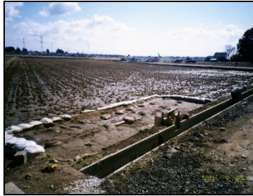
水田を借り入れ沈砂池として利用
