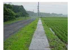
蓋が設置された水路
