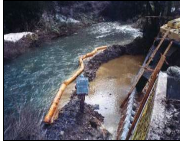
濁水防止フェンスによる抑制
