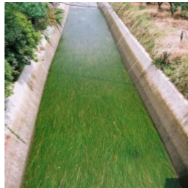
環境配慮対策施工後の水路
