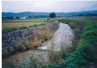
現況の排水路の状況 (流速が速く、魚類の産卵場・生息場としての質は高くなかった)
