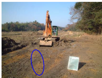
現況表土埋め戻しまでを実施
