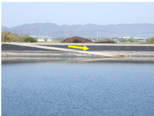
施設内へ下りるスロープの設置例
