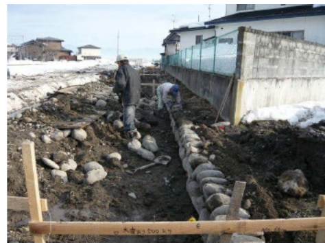
石積み水路の改修 (元泉地域農地・水・環境保全組織 (山形県河北町))
