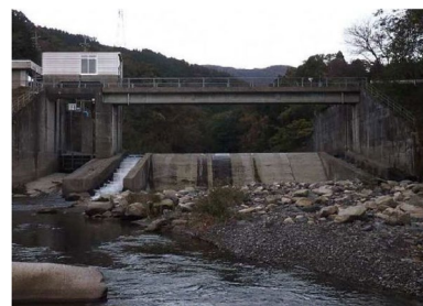
頭首工(改修前)
