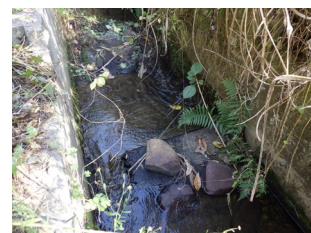
現場打ち魚道
