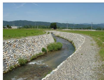
整備後3年目の状況 （多様な流れにより魚類の生息環境の質が向上している。）
