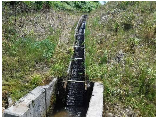
波付きフリュームの設置状況
