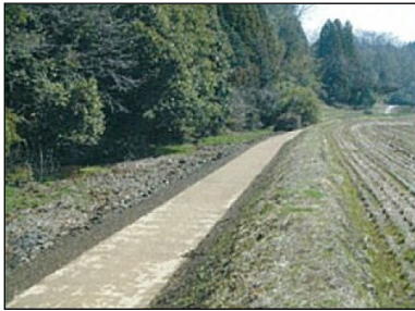
現況水路保全区間
