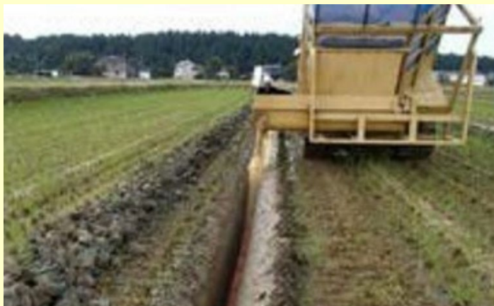
水田下に暗渠排水を設置する様子
