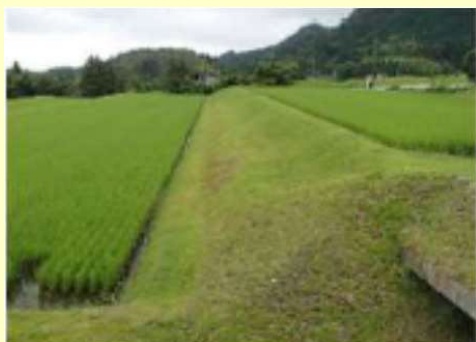
図-3.3.16 長大法面の緩勾配化の事例(法面小段がある場合)
