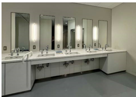
【改修後】洗面台
