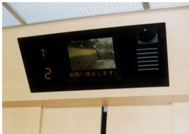
・ 籠内の電光表示（緊急時に文字情報が提供できる。）
