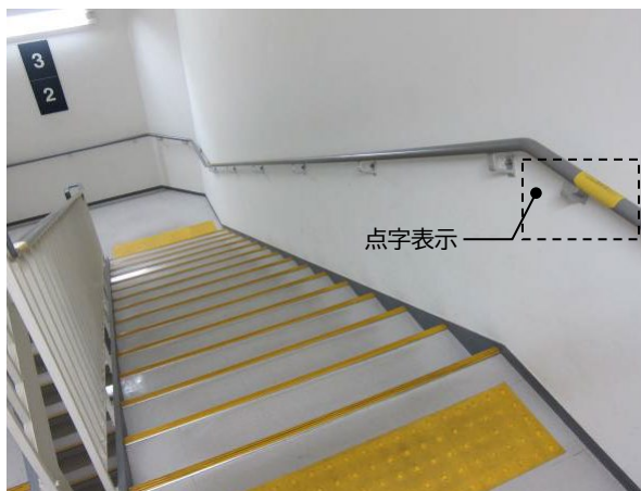
・階段手すりに設けられた点字表示
