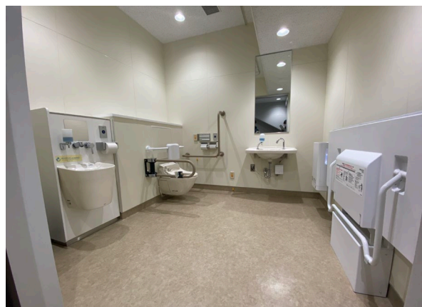
・直径180cm以上の円が内接できるスペースを有する車椅子使用者用便所（大型ベッド付き）
