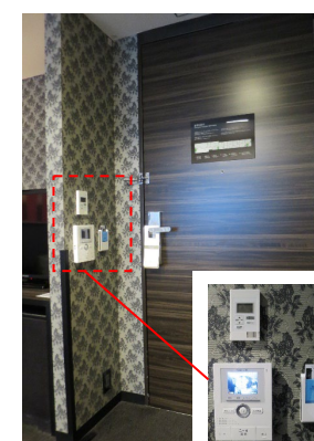
・客室出入口に設けられたカメラ付きインターホン（左）。室内のモニター（右）は床から100cmの高さに設けられている。
