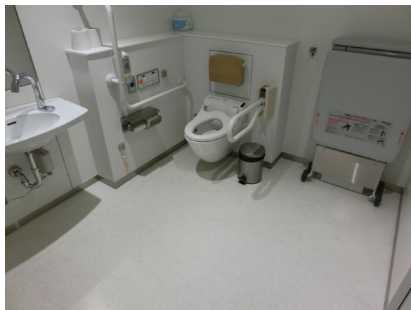
・直径180cm以上の円が内接できるスペースを有する車椅子使用者用便所（大型ベッド付き）
