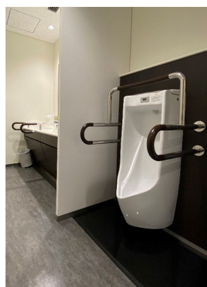
・ 手すりが設けられた小便器
