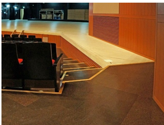
・車椅子使用者用客席の通路から、段差無しで舞台につながる通路
