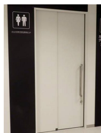
・ 各種男女共用便房の表示と配置例 2 オストメイトの方、乳幼児連れの方、異性による介助・同伴利用等が利用可能な便房
