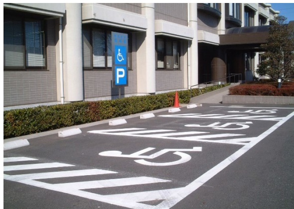
・エントランスポーチの脇に設けられた車椅子使用者用駐車施設(ポーチまでスロープを設けている。)
