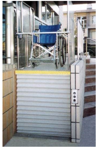
・鉛直型段差解消機
