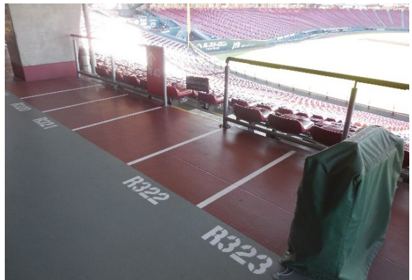
・座席番号がわかりやすく表示され、サイトラインが確保された車椅子使用者用客席（カバーがかかっているのは可動式の同伴者用の客席）
