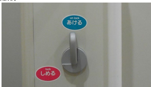
・大きめのレバーハンドル錠、色による戸の施錠／開錠表示（点字表示付）
