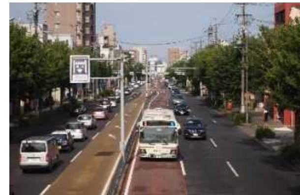
図 道路中央車線にバス優先レーンを整備した「中央走行方式」(名古屋基幹バス)
