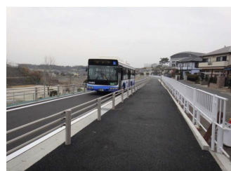
専用道と歩道間に防護柵を設置
