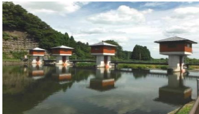
周辺の里山景観との調和に配慮したゲート機械室
