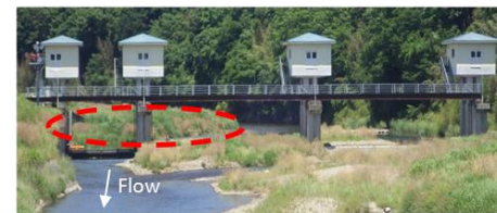
可動堰の上下流に土砂が堆積した事例 (上側:造成直後[1999年]、下側:2016年)
