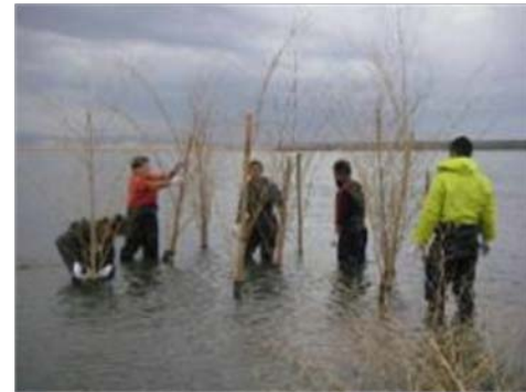
写真10. 逆さ竹林タイプの保護礁設置
