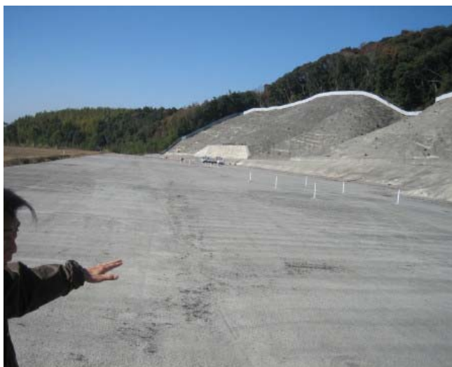
図 5 - 5 場内平坦部コンクリート舗装の例
