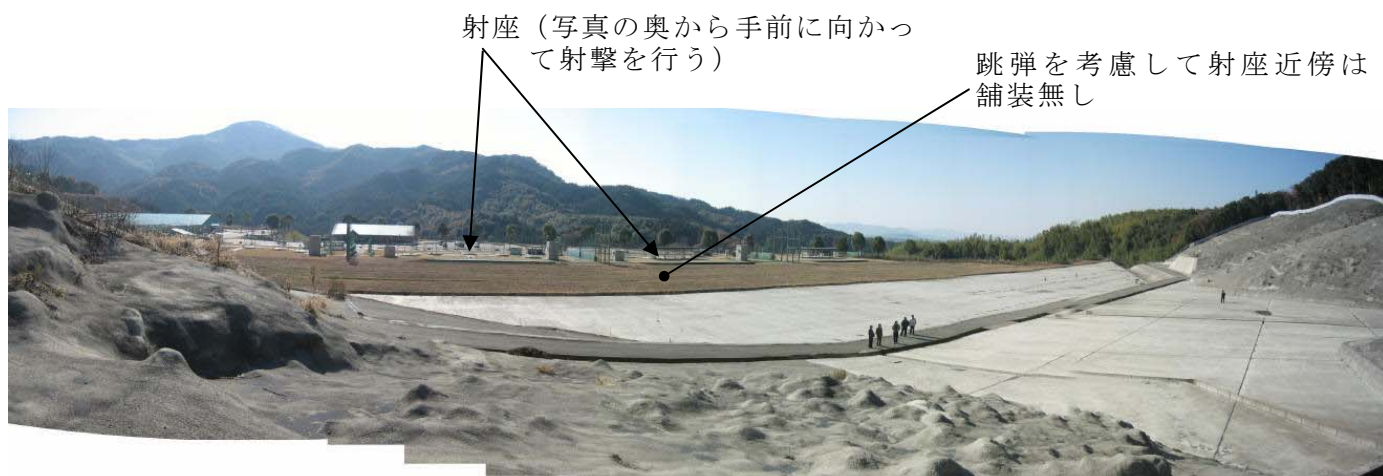
図 5 - 6 舗装面に勾配をつけて鉛弾回収効率の向上を狙った例 （舗装の中央部（人が立っている場所）を低くしている）
