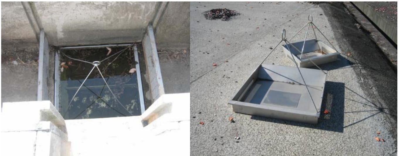
図5－15 排水溝に設置された鉛弾を回収するための網の例
