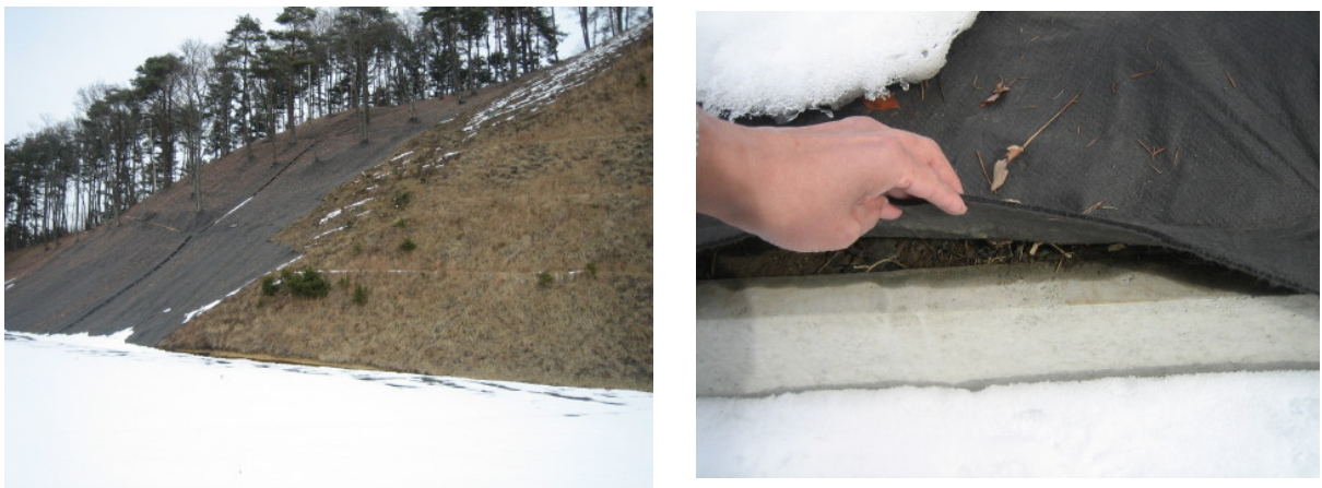
図5-9 シート敷設の例
