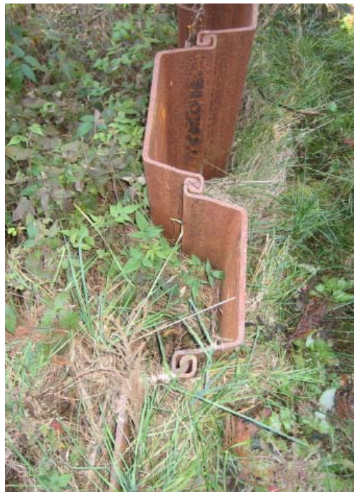
図5－28 遮水壁（鋼矢板）の設置状況の例
