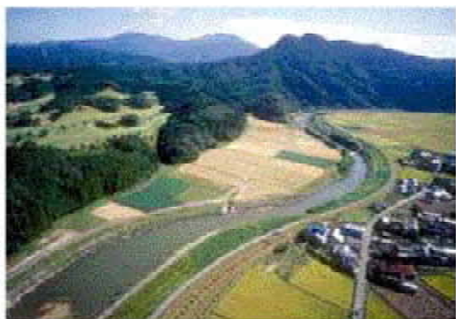
工事前のアザメの瀬（中央の農地）
