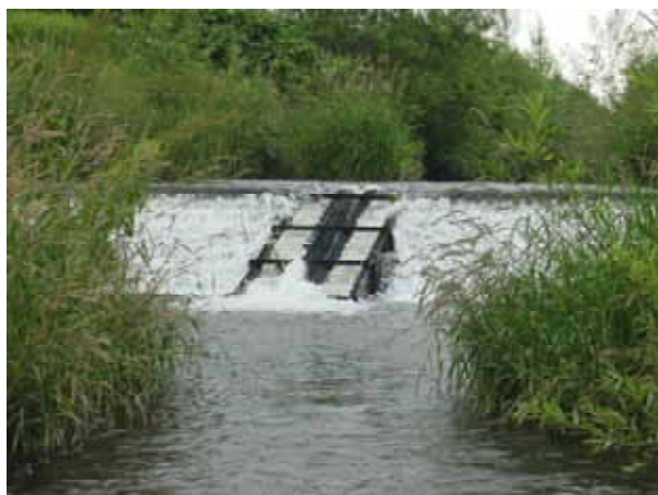
写真１ 設置された魚道
