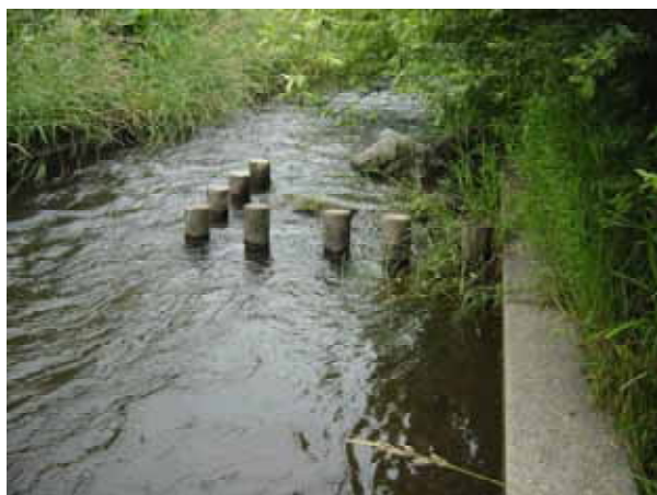
写真２ 設置された水制
